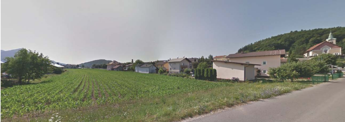
Pogled severozahodne ceste proti jugovzhodu
